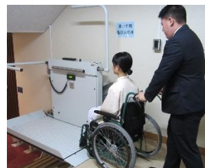
車いす用階段昇降機
